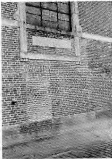
13. Zuidgevel, plint in Balegemse zandsteen
